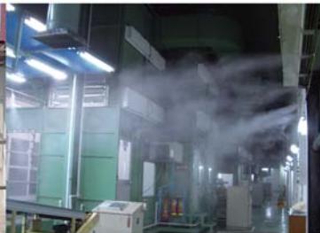
《PAINT PLANT》 《TO PREVENT STATIC ELECTRICITY》
